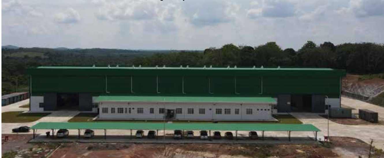
Kompleks Kilang Pemasangan Senjata Berkaliber Besar ADSSB – merupakan satu-satunya Kompleks Kilang Pemasangan senjata berkaliber besar di Malaysia.
